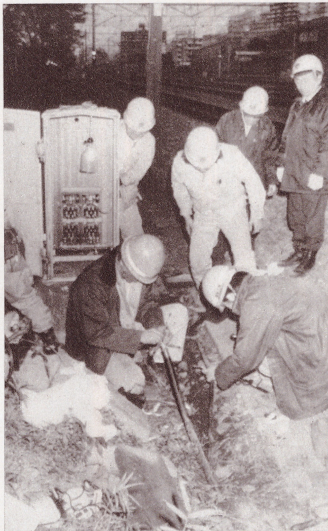
Tecnici delle ferrovie giapponesi cercano di riparare i cavi di comunicazione troncati da militanti del gruppo Chukaku. L'azione del gruppo estremista ha paralizzato Tokyo, lasciando per la strada oltre dieci milioni di lavoratori e studenti.
